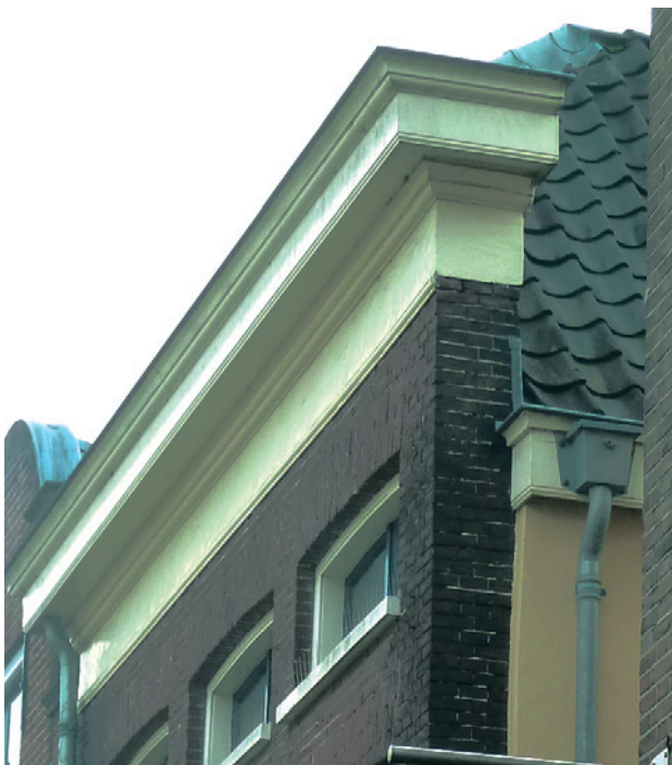
Foto links: de voorgevel, gezien vanuit het zuidoosten anno 2007 9 . Foto rechts: de voorgevel vanaf de 2de bouwlaag vanuit het noordoosten, eind 2020 10 . Schijn bedriegt: de 3de bouwlaag kent minder volume dan de voorgevel doet vermoeden. Dit is het nadeel van een zogenaamde schijnegevel: als het pand zelfs al vanaf één zijde vrij ligt, dan valt de eigenaar een beetje door de mand.
