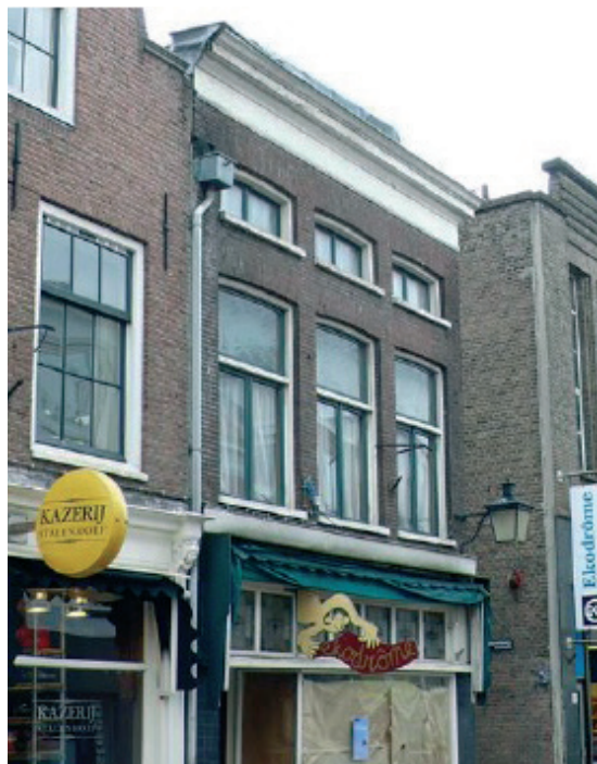
Foto links: de voorgevel, gezien vanuit het zuidoosten anno 2007 9 . Foto rechts: de voorgevel vanaf de 2de bouwlaag vanuit het noordoosten, eind 2020 10 . Schijn bedriegt: de 3de bouwlaag kent minder volume dan de voorgevel doet vermoeden. Dit is het nadeel van een zogenaamde schijnegevel: als het pand zelfs al vanaf één zijde vrij ligt, dan valt de eigenaar een beetje door de mand.
