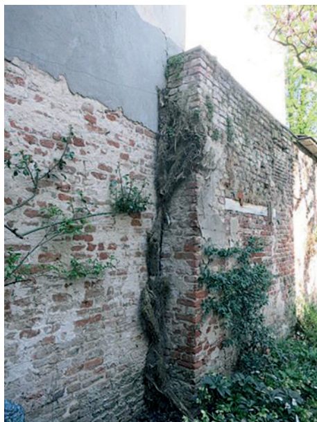
Restant van de 'vrije' muur, nu als oostelijke tuinmuur in gebruik.
