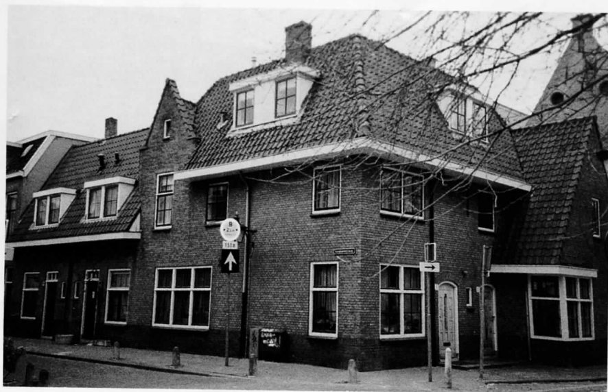
Keukenstraat 50, 52 en Servaasbolwerk 3
