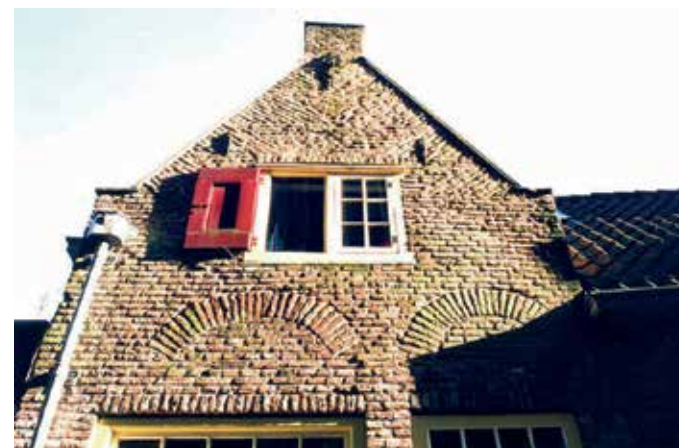
De eerste verdieping van Jacobskerksteeg 25, na de restauratie in 1980.
