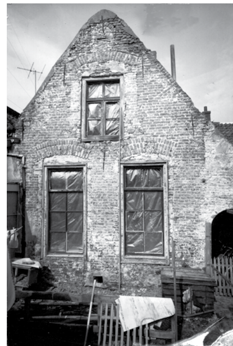
De achtergevel van Zilverstraat 34, voor en na de restauratie. De schouders zijn weer hersteld.
