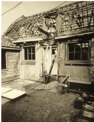
Het grijze vlak op de voorgrond is het platte dak boven de binnenplaats
