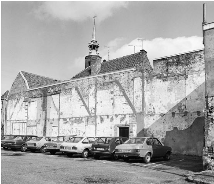
Deze muur (toestand 1970) vormde mogelijk - geheel of gedeeltelijk - de oostelijke zijmuur van de statiekerk. De datering van deze muur door de bouwhistoricus, 1650, suggereert dat in of rond 1650 reeds aanzienlijke bouwactiviteiten aan een kerk hadden plaats gevonden terwijl wij uit de archivalia veel liever concluderen dat rond 1650 nog steeds gebruik werd gemaakt van bestaande, mogelijk doorverbonden gebouwtjes. Was tijdens de inspectie de hele muur ontleisterd of slechts een deel?
