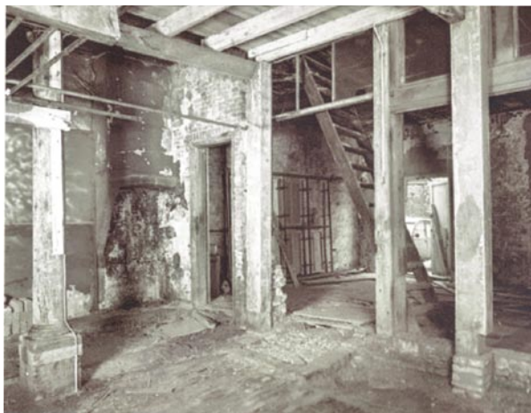
De (hier nog overdekte) binnenplaats tijdens de restauratie. Links een pilaar van het galerijtje.
