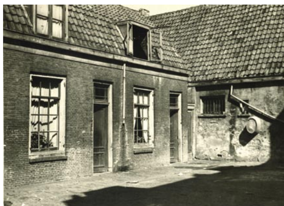
De noordwestelijke hoek van de Hof. Rechts de nog bestaande woning Dorstige Hartsteeg nummer 13. Zie ook de tekening op blz. 31.
