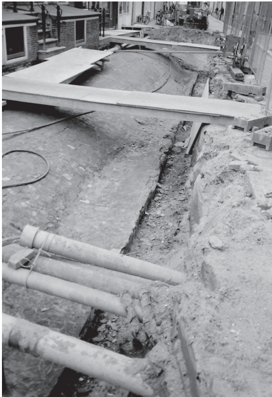
Opgebroken Lange Smeestraat gezien vanaf de Smeeburg met keldergewelf van de straatkelder OG279, d.d. 26-9-2001.
