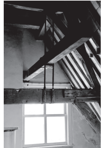
De hijsbalk die op zolder boven het raam in de zijgevel naar buiten kan worden geschoven.
