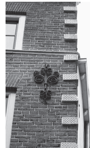
Waterlijst, hoekblokken en anker in één oogopslag.
