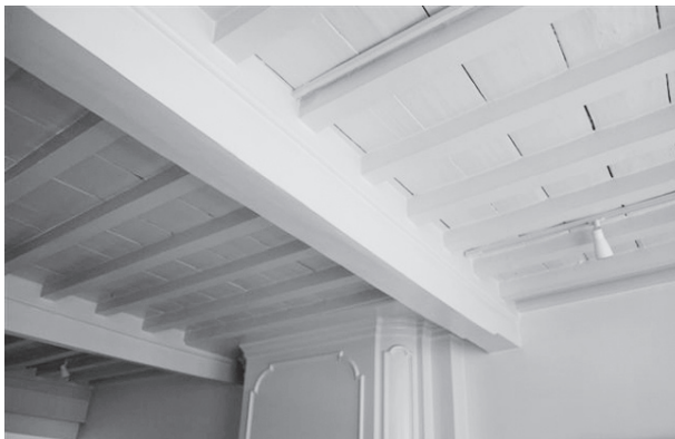
De samengestelde balklaag met moer- en kinderbalken is nog te zien op de eerste verdieping.
