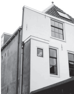
De achtergevel met de twee verdiepingen hoge toilet-uitbouw.
