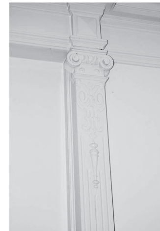
Een van de pilasters van de pilasterstelling in de beneden-voorkamer
