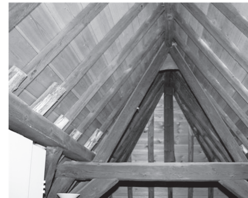
Boven: de dakconstructie met vrijstaande spanten onder: de telmerken.
