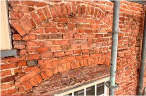
Voorgevel Springweg 116 met de ontlastingsboog van de verdwenen poort.
