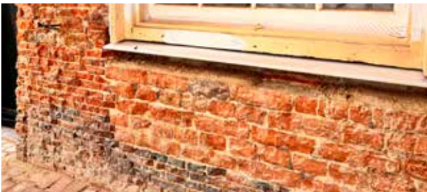
Verschillende soorten ingeboet metselwerk en steenformaten.
