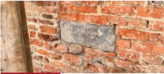
Blok natuursteen en een dagkant, onderdeel van de verdwenen poort.
