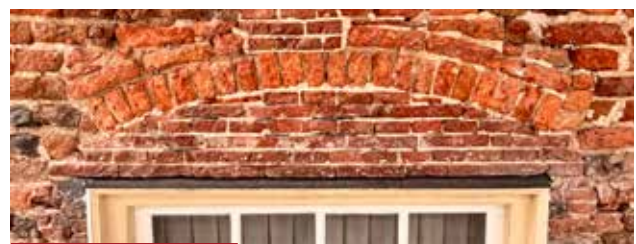
Ontlastingsboog die behoorde bij een eerder (iets smaller) venster.
