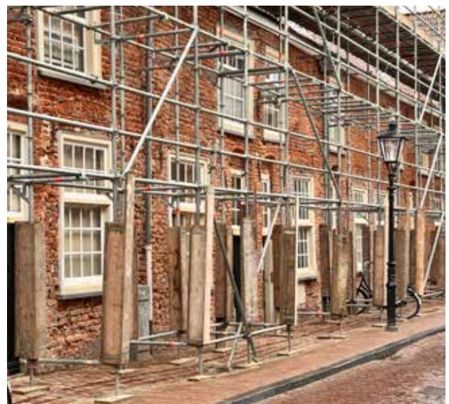
Voorgevel van Springweg 118 – 128 na ontpleisteren.
