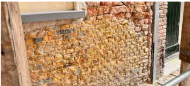
Verschillende soorten ingeboet metselwerk (hier ijsselsteentjes) en steenformaten.
