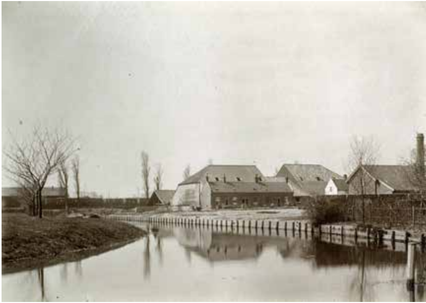
De schuur met de dubbele steenoven van Voorzorg op een foto uit 1890. De haven is in 1869 aangelegd en de vijf nieuwe meerkamerwoningen zijn gebouwd in of kort na 1888
