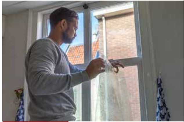
Plaatsen van raamfolie in een woning door Revisi
