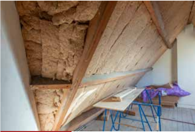
Isolatie van de kap van Wulpstraat 37 d.m.v. isovlas
