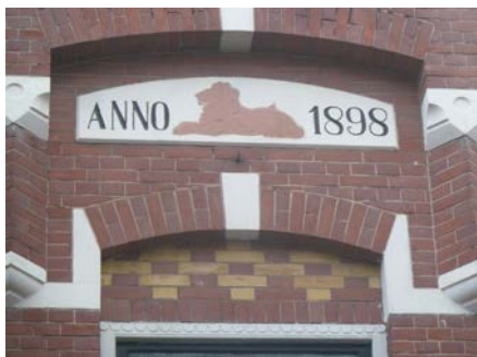
Foto links: de eerste verdieping en dakkapel; rechts: gevelsteen oranje leeuw met jaartal 1898.
