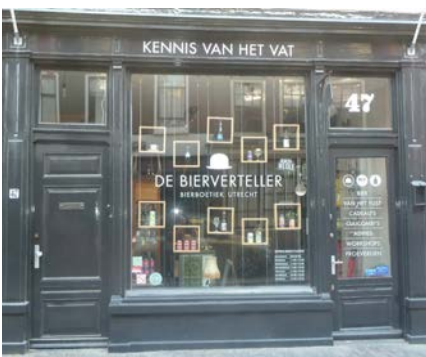
Nr. 47: 19de-eeuws, houten pilasters, paneeldeuren en een hardstenen plint; achter pand 19de-eeuws pakhuis aan de Twijnstraat aan de Werf;
