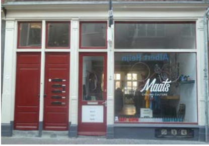
Nr. 7: 1889, pui-indeling logisch gezien loodgietersambacht opdrachtgever; huisde tevens kleermaker/tailleurs en later rijwielabriek Van der Wal;
