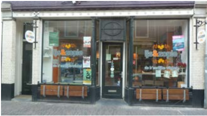
Nr. 79: 1905, overgangsstijl; gietijzeren puibalk, pilaren en kapitelen; voorbeeld voor in ieder geval de winkelpui van nummer 22;
