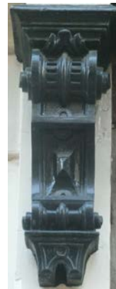
De rechterconsole, bovenin is de genoemde engelenvleugel te zien. Op ornamenten toegepaste verkleuren maken veel verschil: op een HUA-foto van 1974 springen de details er meer uit, de verkleur was toen wit.
