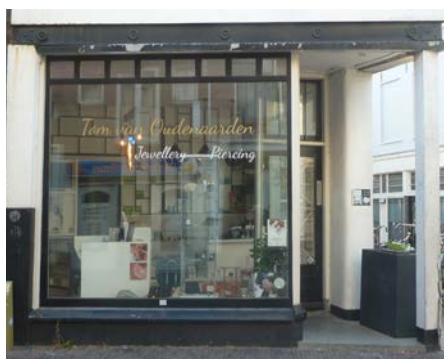
Links: het Twijnstraat-geveldeel, rechts: het Nicolaasstraat-geveldeel. Zie de gestileerde bloemen op het gietijzeren fries, de sierlijke geklinknagelde hoekverbinding en het dito gietijzeren muurankertje in de Nicolaasstraat. De gestileerde bloemen zijn feitelijk versierde piercings, met een fris nieuw verfje zou het fries een uniek reclamemiddel kunnen worden.
