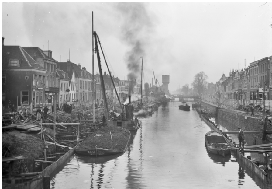
Gezicht op de Vaartsche Rijn te Utrecht, vanaf de Tolsteeg-basculebrug, uit het noorden, tijdens de werkzaamheden aan de kademuren van de Oosterkade (links) en Westerkade rechts (1931).
