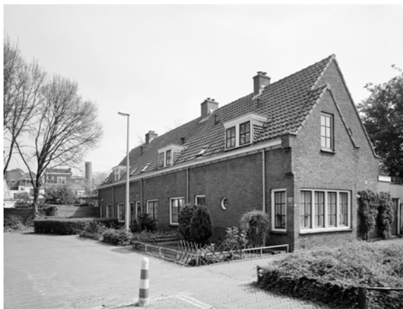
Gezicht op de voorgevels van de huizen Wulpstraat 2, 4, 6, 8 en 10 (rechts) (1999).
