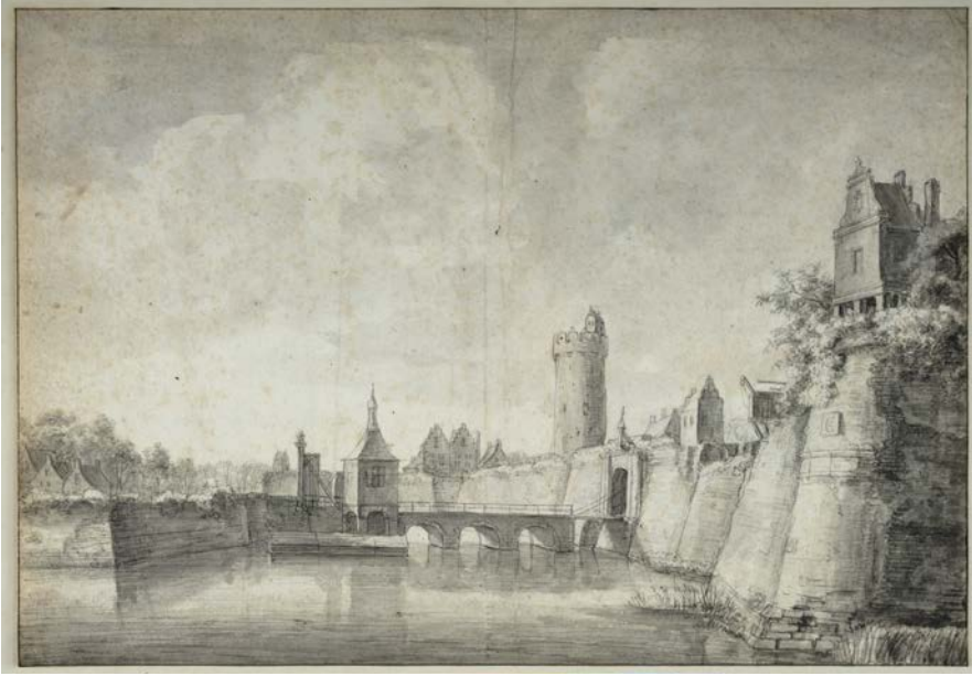
Gezicht over de Stadsbuitengracht te Utrecht op de stadsmuur met de Tolsteegpoort en -brug uit het oosten, met rechts het bastion Manenburg en middenachter het dubbele woonhuis op het bastion Sterrenburg en de Bijlhouwerstoren (1680).
