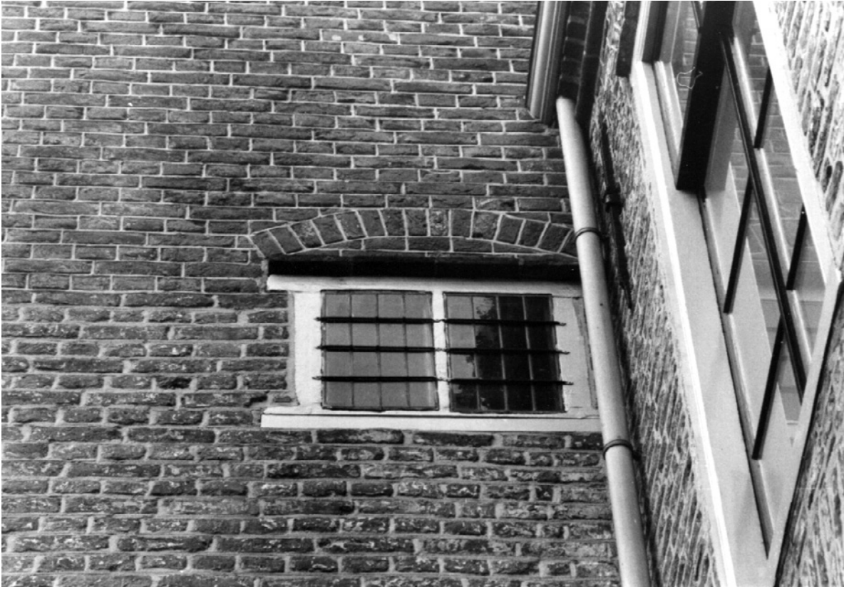
Het bolkozijn in de traptoren.
