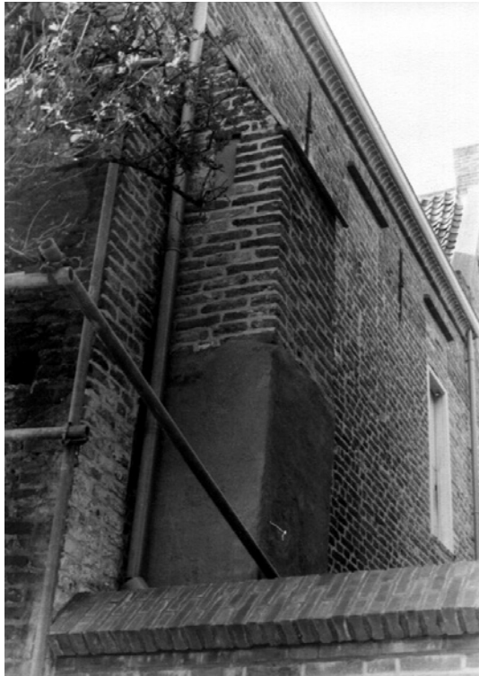
De hangplee tegen de noordmuur.
