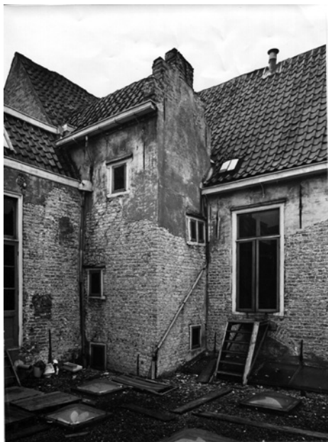
Boven: De traptoren, nog voor de helft afgedekt door de drukkerijhal die nog niet is weggebroken.
