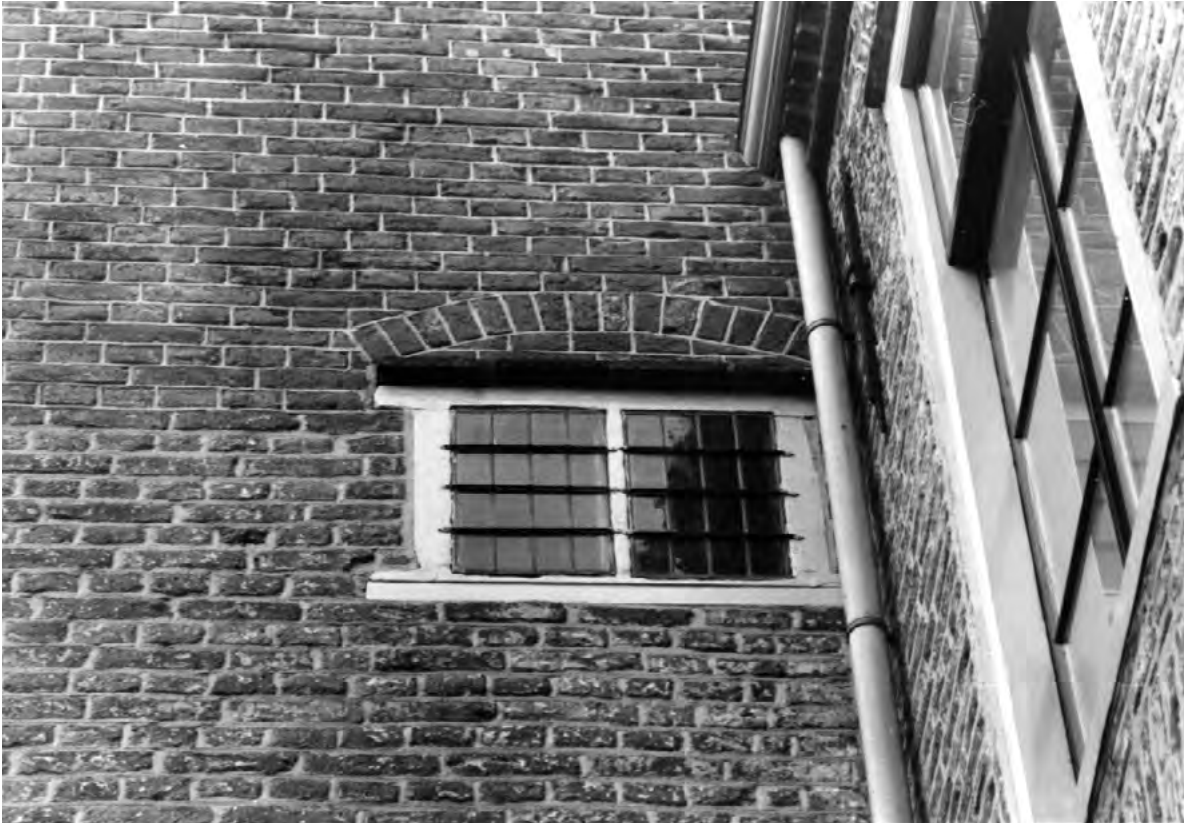
Het bolkozijn in de traptoren.
