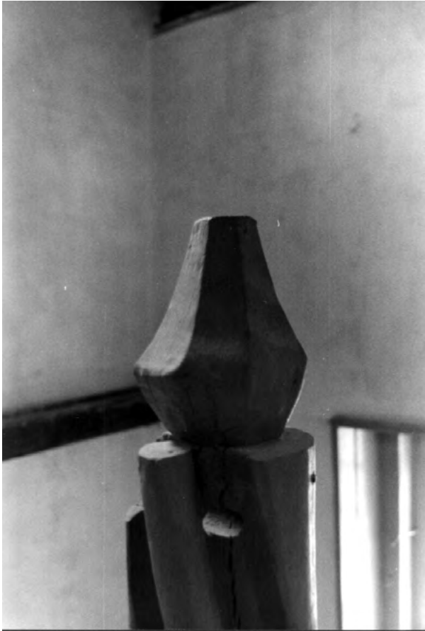
De spiltrap in de traptoren. Links: de peervormige bekroning, onder: de in de spil gehakte handgreep en de oortjes aan de treden.
