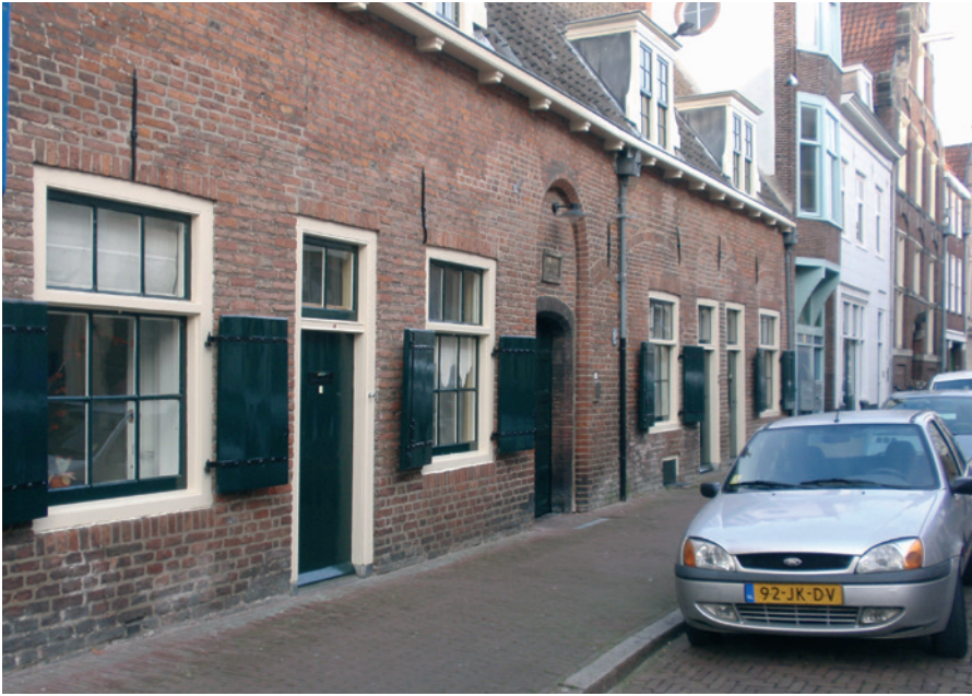
De voorgevel aan het Jansveld in 2020.
