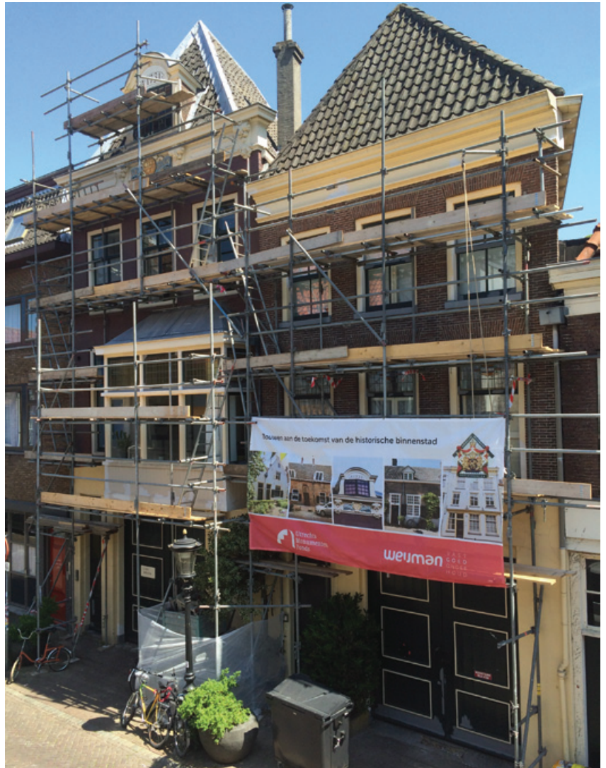
▲ De 17e-eeuwse panden op Jansveld 9 en 11 worden door Weijman Vastgoedonderhoud in opdracht van het Utrechts Monumentenfonds onder handen genomen. Nu twee woningen, maar begin 20e eeuw zetelde hier de Utrechtse Taxi Onderneming, nog te zien aan ‘garagedeuren’ in de gevel.
