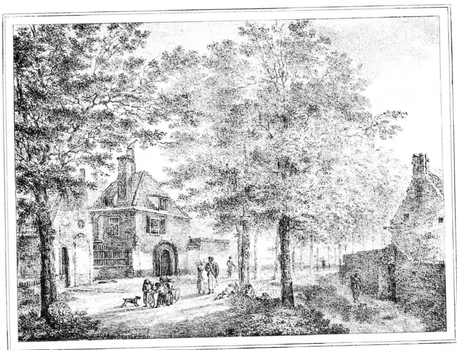
HET BOLWERK ZONNEBURG (op de Wal)
