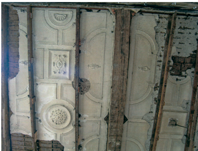
Het stucplafond in de kamer rechtsachter.
