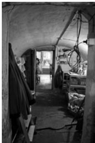
De oostelijke tussenkelder
