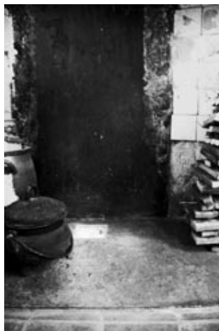
Dichtgesmeerd asgat in de liggende plaat.
