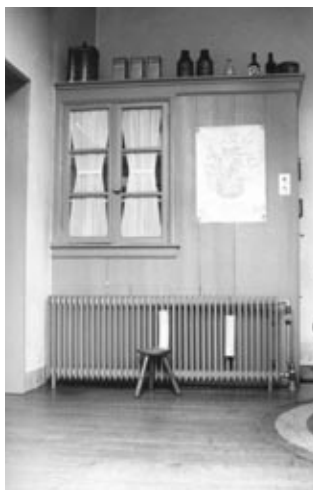
De houten ombouw van de keldertrap (foto: AW)
