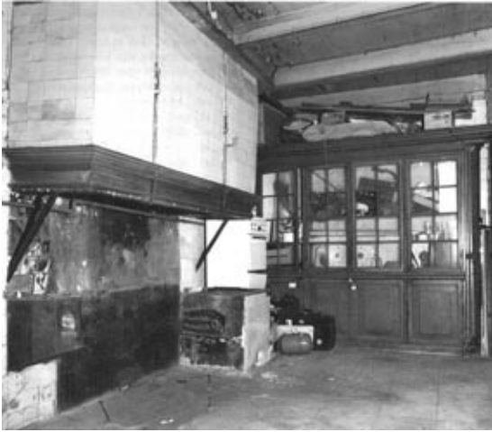
Van de keuken van Cranestein, nu Oudegracht 53-55, is de achttiende-eeuwse vorm bewaard gebleven. We zien de grote rookkap, witte betegeling, de keukenkast, een gemetselde oven (waarop tijdelijk een gasfornuis is geplaatst) met de ovendeur aan de schouwzijde, en een klein warmhoud-oventje links. (foto: ABC)
