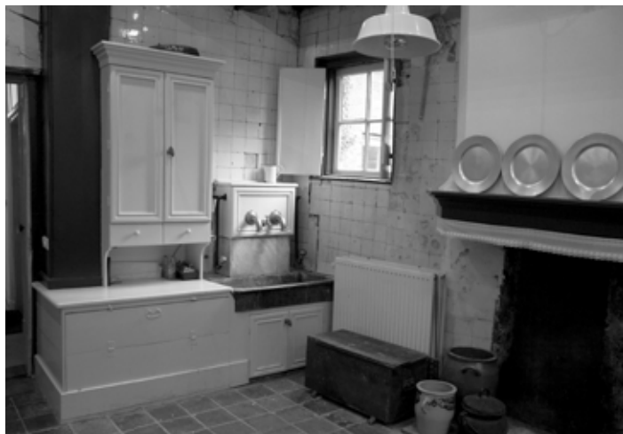
Zicht op de oost- en een deel van de zuidmuur van de keuken. Van links naar rechts: gangdeur, turfstortkoker, turfhoek met daarop de kast, hardstenen gootsteenbak met dubbele pomp. In de zuidmuur het raam met luiken. Daaronder een laat 20e-eeuws verwarmingselement. Ten slotte rechts, gedeeltelijk te zien, de grote schouw.
