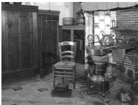
Veel zorgvuldiger en fraaier dan in de hiernaast afgebeelde Staphorster boerderij is de verandering van een open naar een gesloten vuur uitgevoerd in een keuken van het Begijnhof in Brugge. We zien een nieuw schoorsteenkanaal van schoon metaalwerk met een bescheiden schoorsteenmantel en een fraaie plattebuiskachel die flink ver in het vertrek is geplaatst.
