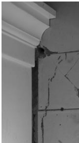
Verfsporen op de tegels als vormaanzijning bij de herbouw van de kast.
