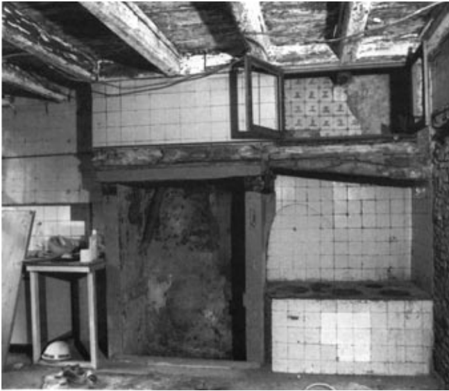
18e eeuwse keuken in Twijnstraat 45. Het gemetselde fornuis werd vanuit de schouw gestookt. (foto: ABC)
