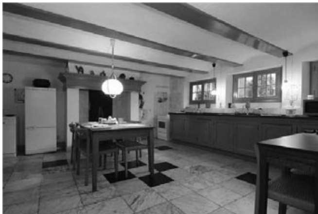
Nieuwe Gracht 159, onder het maaiveld, met troggewelfjes tussen de balken.
