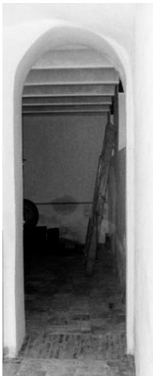
De doorgang in de kelder naar het keldertje van de keuken. (foto: AW)
