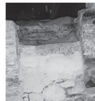
Lichtopening/kolenstort in achtergevel voor en na herstel..
