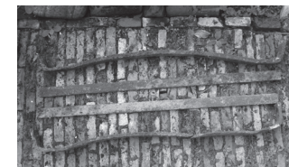
Steunijzers uit het keldergewelf.
