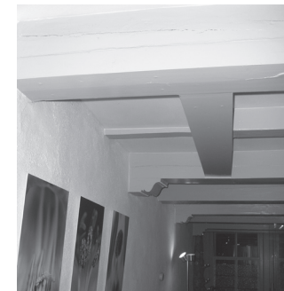
Details van de balklaag op de begane grond. De balken zijn aangeheeld en voorzien van nieuwe sleutelstukken.
