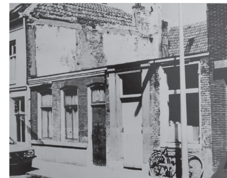
Zicht op de zuidgevel van Springweg 154 tijdens de afbraak van nummer 156 en 158.
