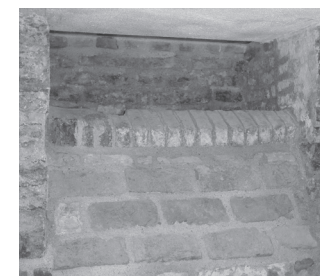
Lichtopening/kolenstort in achtergevel voor en na herstel..
