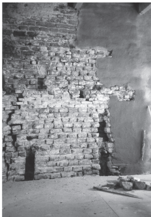
De afdruk van de spantvoet in het metselwerk van de voormalige borstwering is goed te zien.
