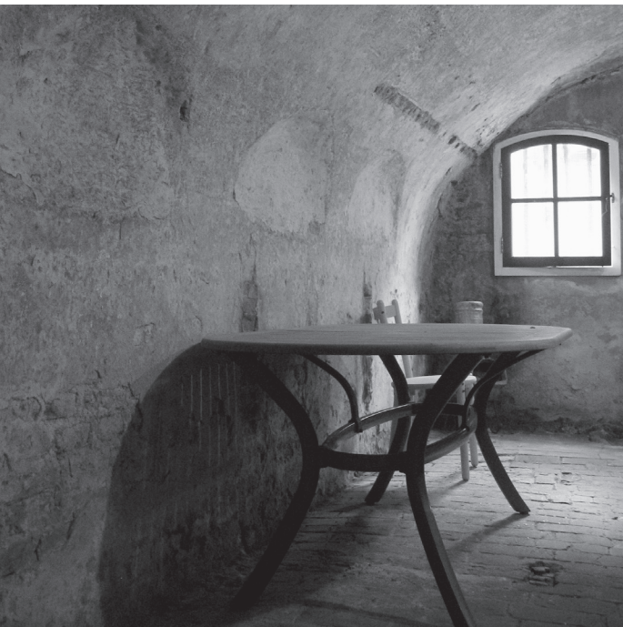
Boven de tafel zijn in de kelderwand drie uithollingen te zien voor het plaatsen van grote wijnvaten
