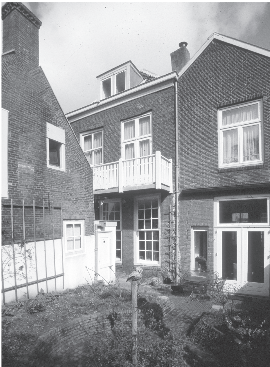
De achterzijde van het huis, met links het keukengebouwtje (linksboven is nog net een deel van de deur naar de turfzolder te zien) en de buiten-uc voor het personeel. Onder het balon de originele ramen uit 1733. Rechts het zijhuis uit 1854 op de plaats van de voorste twee kamers van Doeijenburg. Op de voorgrond 'het tuintje van meneer den Daas'.
