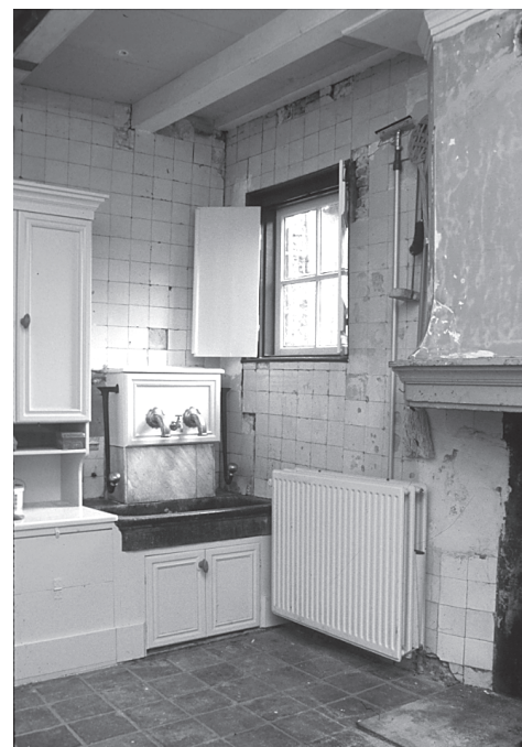
De oude keuken uit 1733/34. Rechts de grote schouw met haardplaat. Links, onder de kast, het turvenhok voor de dagvoorraad. Midden de dubbelpomp met de hardstenen gootsteen.
