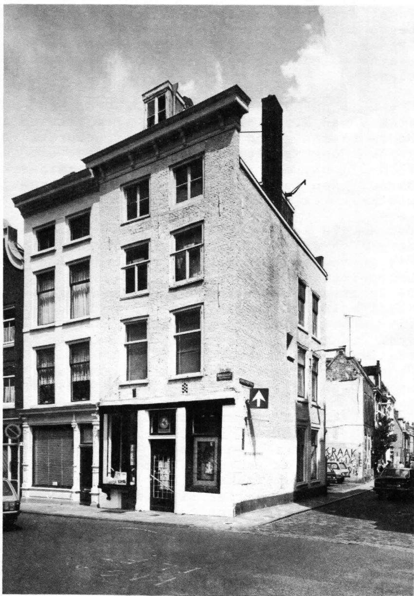
Oudegracht 302 voor restauratie
