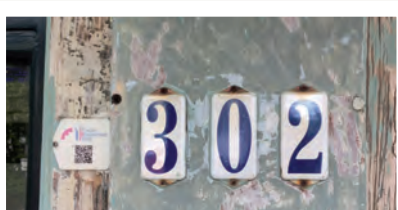
▼ Kaal kozijn Oudegracht 302
