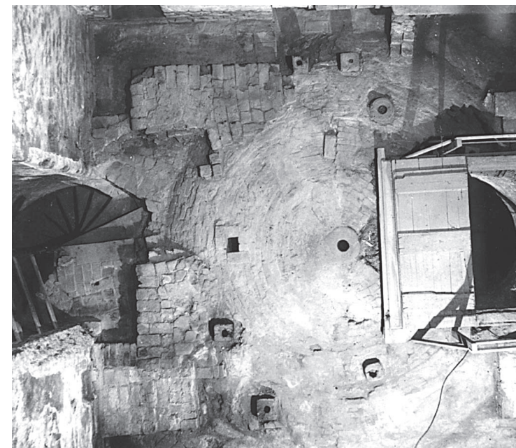
Afbeelding 2. De stenen vloer van de klokkenkamer in de tweede torengeleding, schoongemaakt in verband met de restauratie, van bovenaf gezien. Het oosten is boven. Het gewelf van het portaal is zichtbaar en de plaats van de voet van de 14e-eeuwse klokkenstoel is te herkennen. Zichtbaar zijn ook de doorvoergaten voor de luidtouwen. F Dienst Openbare Werken 1944
