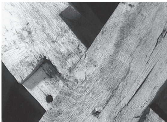
Afbeelding 5. Bij deze houtverbinding is goed te zien dat hergebruik van ouder materiaal heeft plaatsgevonden: de uitsparingen die zichtbaar zijn in de balk die naar links gaat zijn van een eerdere constructie.
