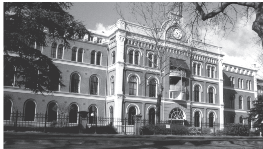
11. Het voormalig AZU-hoofdgebouw aan de Catharijnesingel. (Foto auteur)
