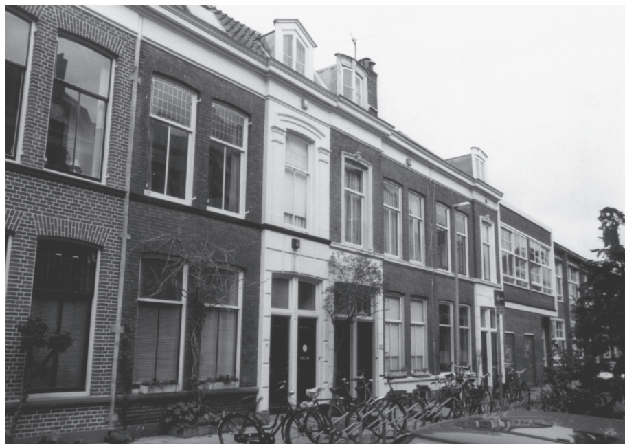
14. De huizen Parkstraat 26 - 30bis met door stucwerk benadrukte entrees. (Foto auteur)
