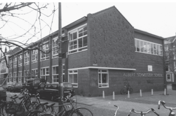
7. Het schoolgebouw uit 1955 aan het Schoolplein. (Foto auteur)
