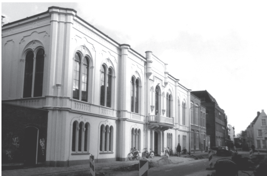
12. Het pand Van Asch van Wijckskade 28. (Foto auteur)
