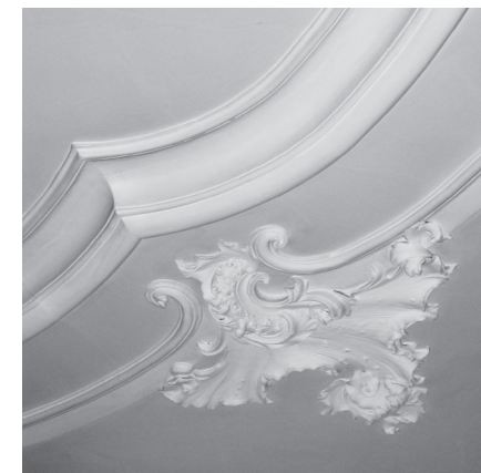
Detail van het stuc-plafond in de tuinkamer.
