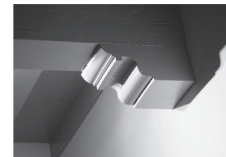
Boven: origineel sleutelstuk uit ±1630, in de balklaag boven de begane grond, gedeeltelijk zichtbaar. Onder: kopie daarvan gebruikt ter vervanging van de zwaar beschadigde exemplaren in de balklaag boven de verdieping.
