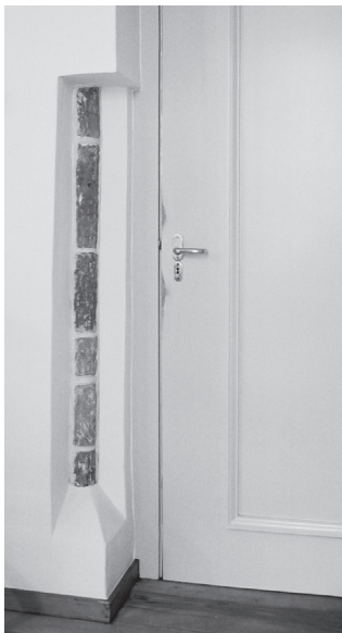
Afb. 4. Het rondstaafprofiel van de laat 13e-eeuwse ingang in de noordmuur.
