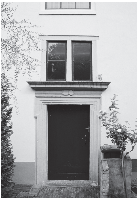
Afb. 11. Zandstenen poort met alliantiewapens in de zuidmuur.
