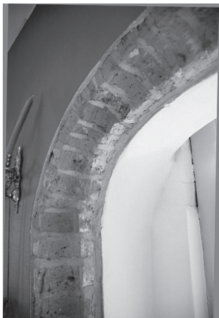
Afb. 7. Het bakstenen holprofiel aan de buitenzijde van de nieuwe hoofdingang.
