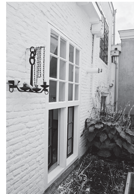
Afb. 17. Kruisvenster in de noordmuur van de verdieping.
