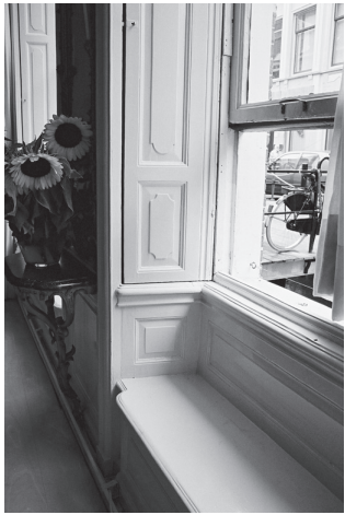
Afb. 24. Schuiframen met binnenluiken en luikkasten, 1743.
