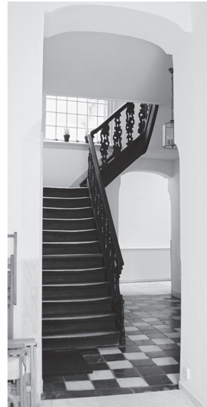
Afb. 22. De houten trap met door Adriaan Beertens gesneden balusters.
