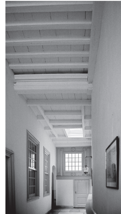
Afb. 26. De gang (het voorhuis). Links de deur naar de voorkamer aan de gracht en de ramen van de "middelkamer" die vroeger alleen licht kreeg van het bovenlicht aan de plaats. Tegenwoordig is er ook een daklicht.
