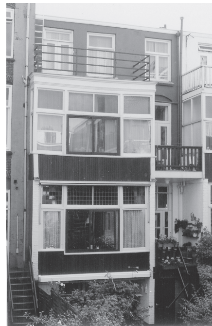
De achtergevel vóór de restauratie
