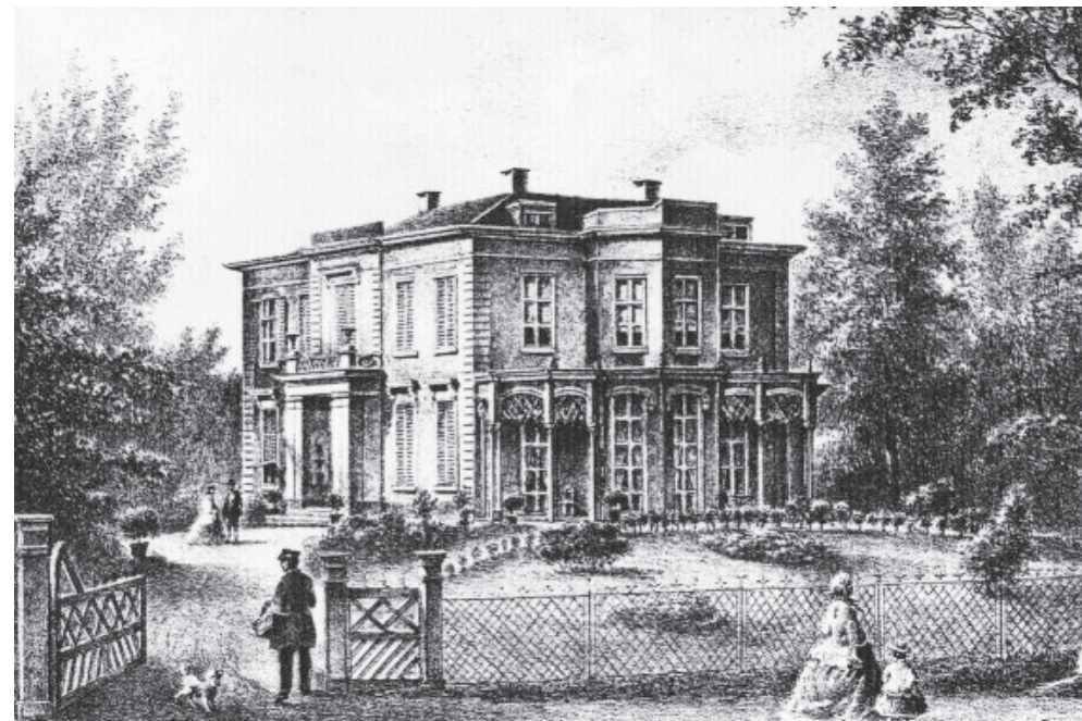
Omstreeks 1822 liet J.H. Cazius de villa Voorzorg bouwen aan de voorzijde van het terrein aan de Catharijnesingel, ter hoogte van de huidige woningen 70 t/m 73. Het huisadres van de villa was Singel wijk L nr. 213. Steendruk van J.D. Steurwald naar een litho van P.J. Lutgers.
