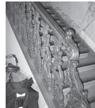
Roëll wilde geen hooi en mest door zijn huis. Nu staan er stalen rossen in de gang.
