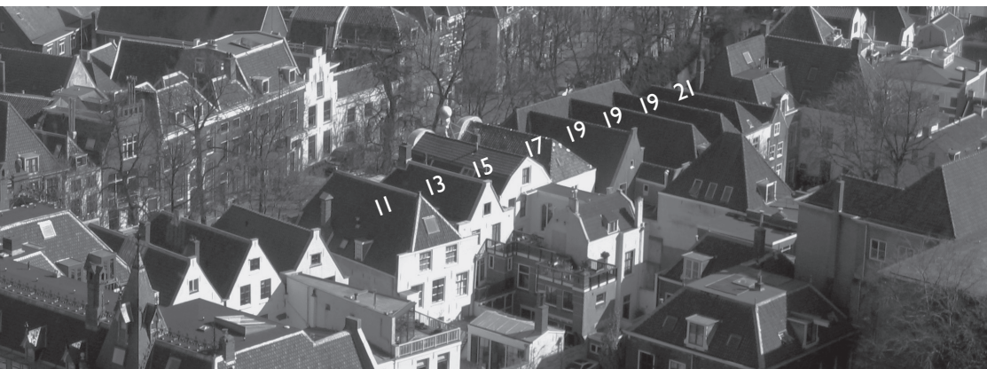
De huizen aan de Runnebaan, gezien vanaf de Domtoren. In de noordelijke dakvlakken zijn met witte cijfers de huisnummers aangebracht.
