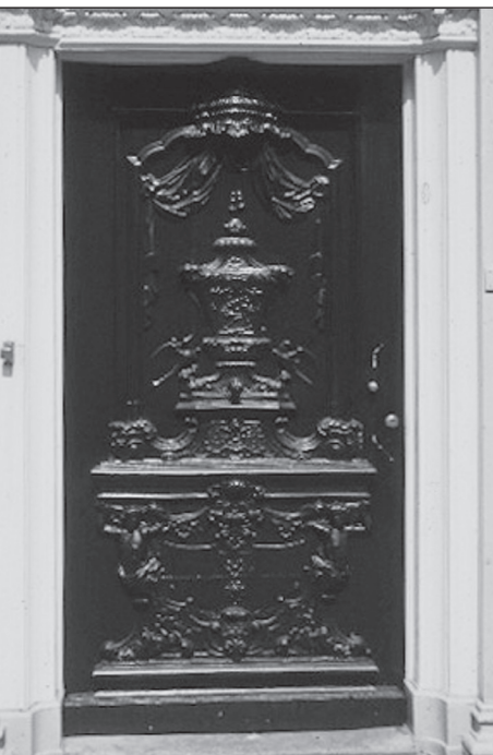
Voordeur Kromme Nieuwegracht 43, ca 1725, gesubsidieerd 1954 (foto C.L.T.G. 1966).
