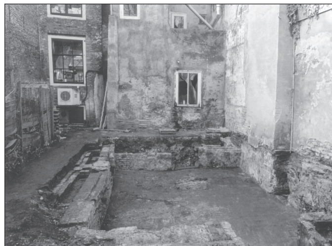
Fundament Mariastraat 14, gezien richting Mariastraat.
