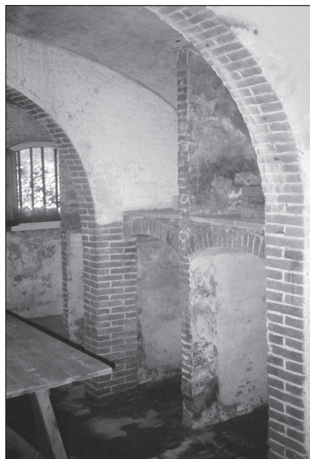
Deel van het interieur van de kelder in het bruggehoofd van de Brigittenbrug. Het is nog steeds te zien dat er vroeger wijn werd opgeslagen.
