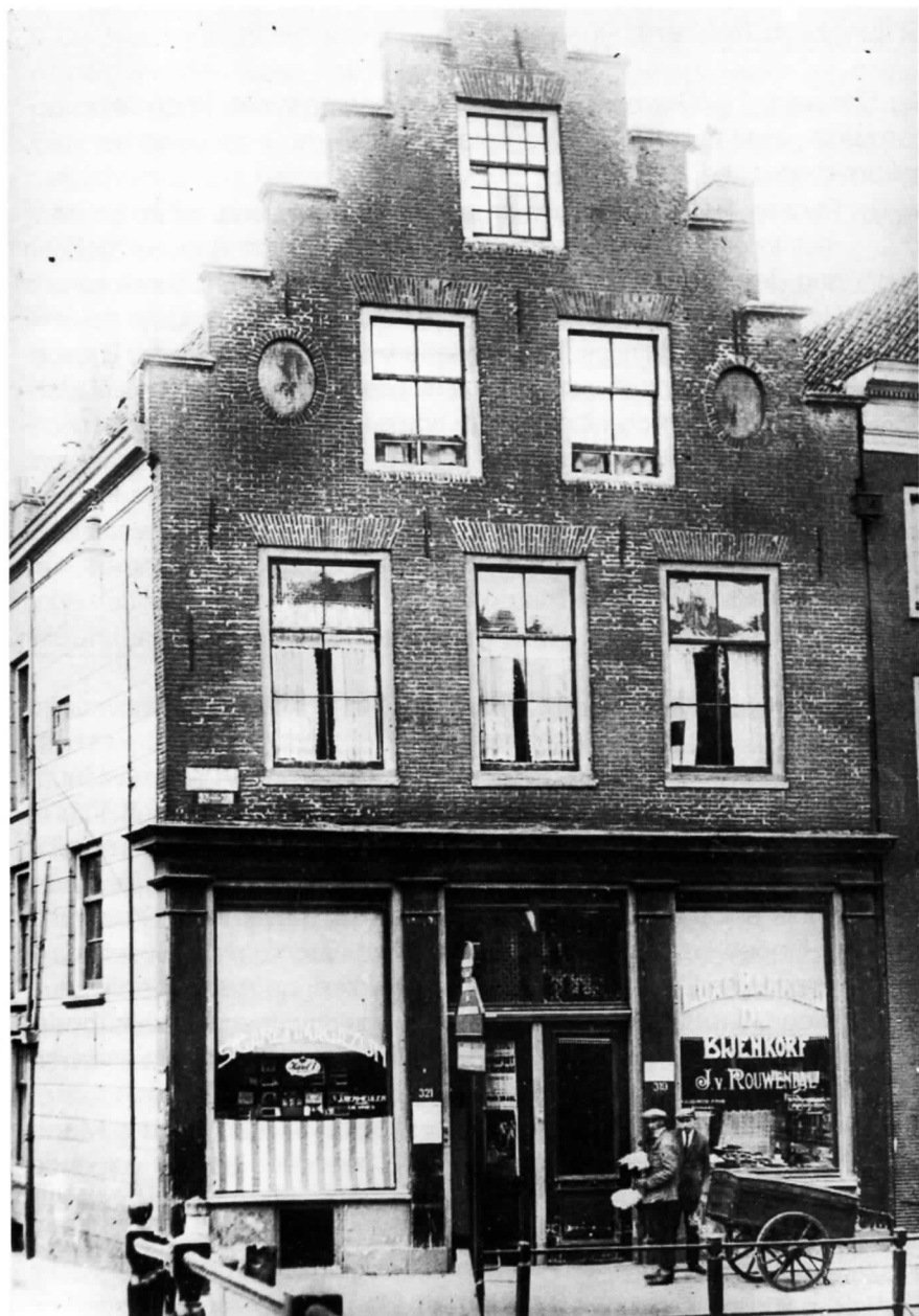
Grijsesteijn voor de restauratie van 1930 (Foto: GAU/TA)
