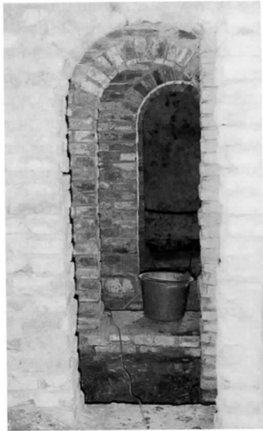
De met muurtjes gestutte kelder onder de voorzijde van nr. 321.
