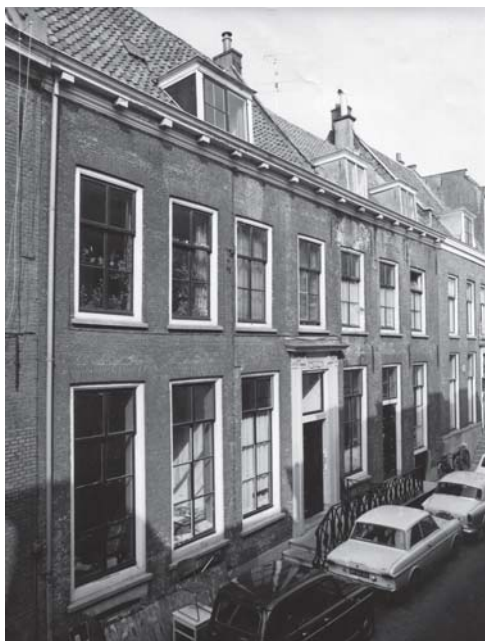
▼ Brigittenstraat vóór renovatie
